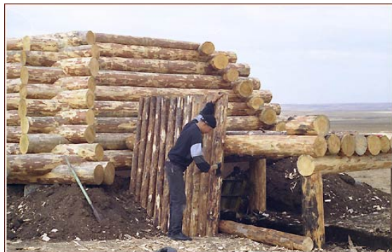
Рис. 2.165. Реконструкция жилого строения
